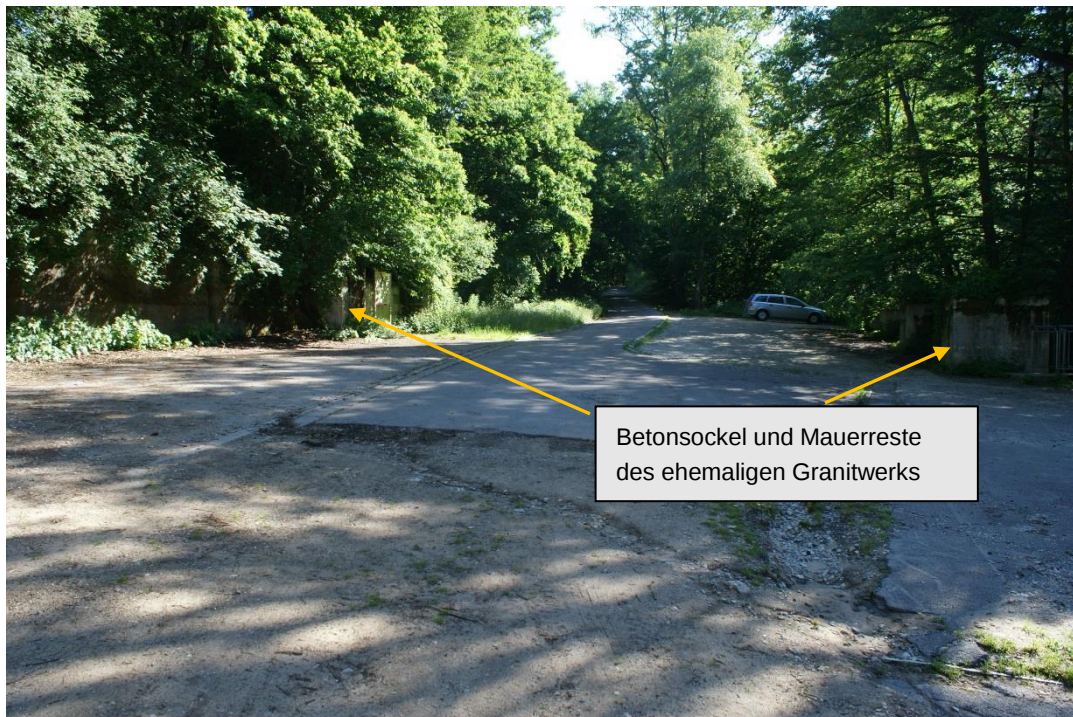
Östlicher Geltungsbereich des GOP mit Zufahrt Hammerwerkstraße und beidseits vorhandenen Mauerresten und Betonsockeln des ehemaligen Granitwerkes (Hammerwerk)
