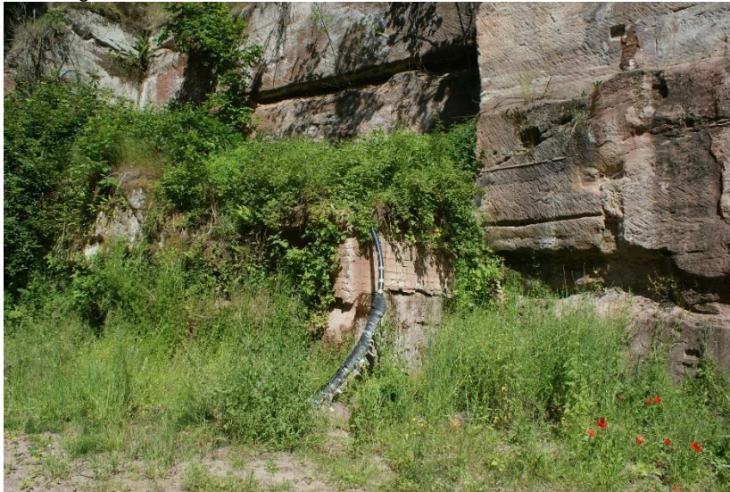
Leitungs-(kabel)Fragment sowie Mauerreste
