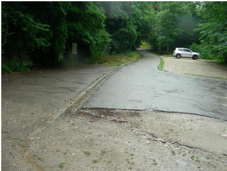
Hammerwerkstraße im östlichen Abschnitt des Geltungsbereiches mit PKW-Stellplatz sowie Asphalt- und Schotterflächen für Teilentsiegelung
