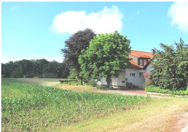
Bild 1: Ochebrucker Straße Wohnhaus 39 mit gewerblicher Nutzung
